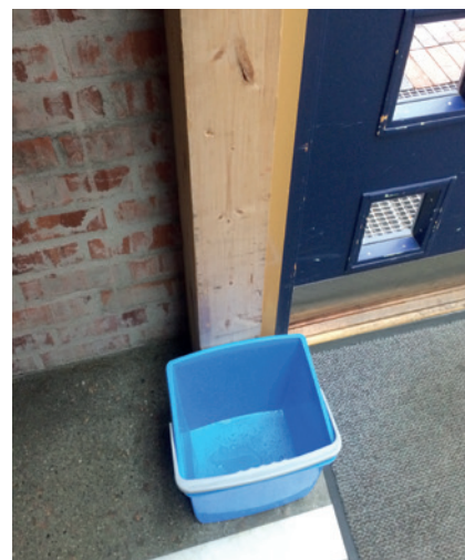
Rehabilitering av Åmot kirke.
