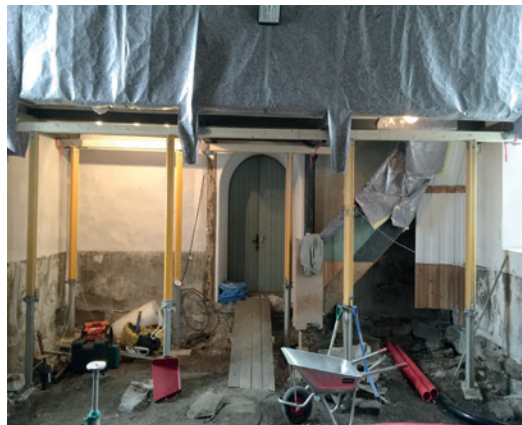
Fra arbeidet i Heggen kirke
