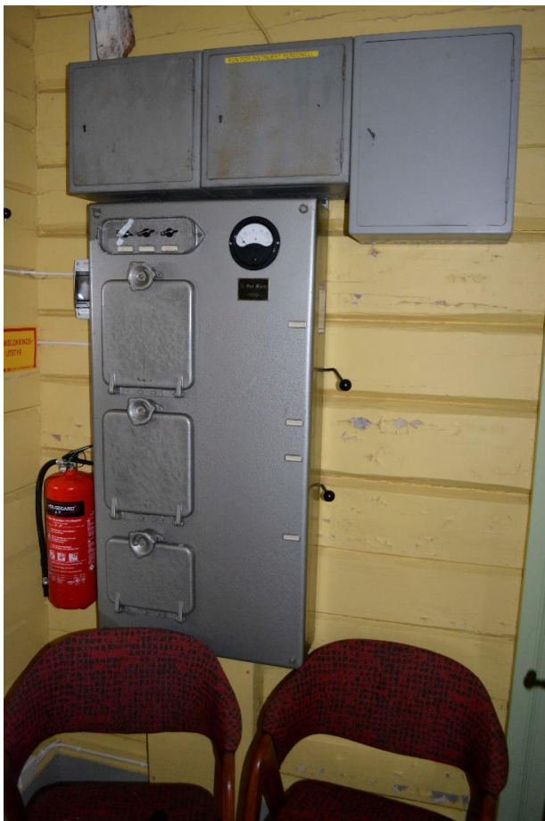
Gammelt sikringskap. Utstyret er ikke lenger godkjent for vanlig bruk
