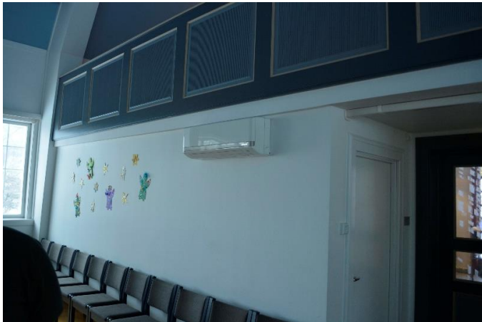
Plassering av innerdel for varmepumpe i kirkesalen
