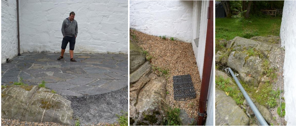
T.v.: Ny hellelagt plattning for å hindre fuktoppsamling i hjørnet. Midt: Ny dreneringsmasse. T.H.: Opprensning av fjell og dreneringsrør.
