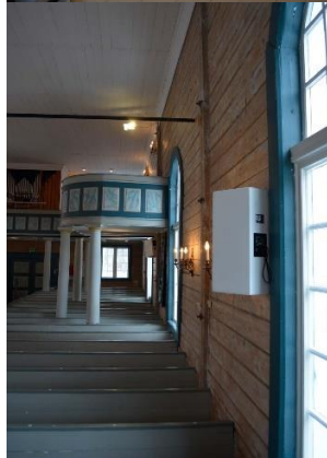
Det er satt inn to strekkfisker for å hindre ytterligere utbuling av vegger (18/03508)
