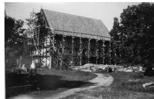
Kirken gjennomgikk en grundig restaurering både innvendig og utvendig. Foto: Ivar Bruu.
