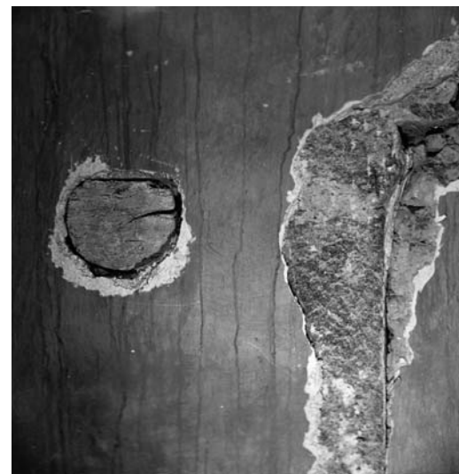
En bjelke fra østgavelens takkonstruksjon ble funnet inne i kirkemuren. Denne ble datert til år 1000 +/- 80 år. Foto: Ivar Bruu
