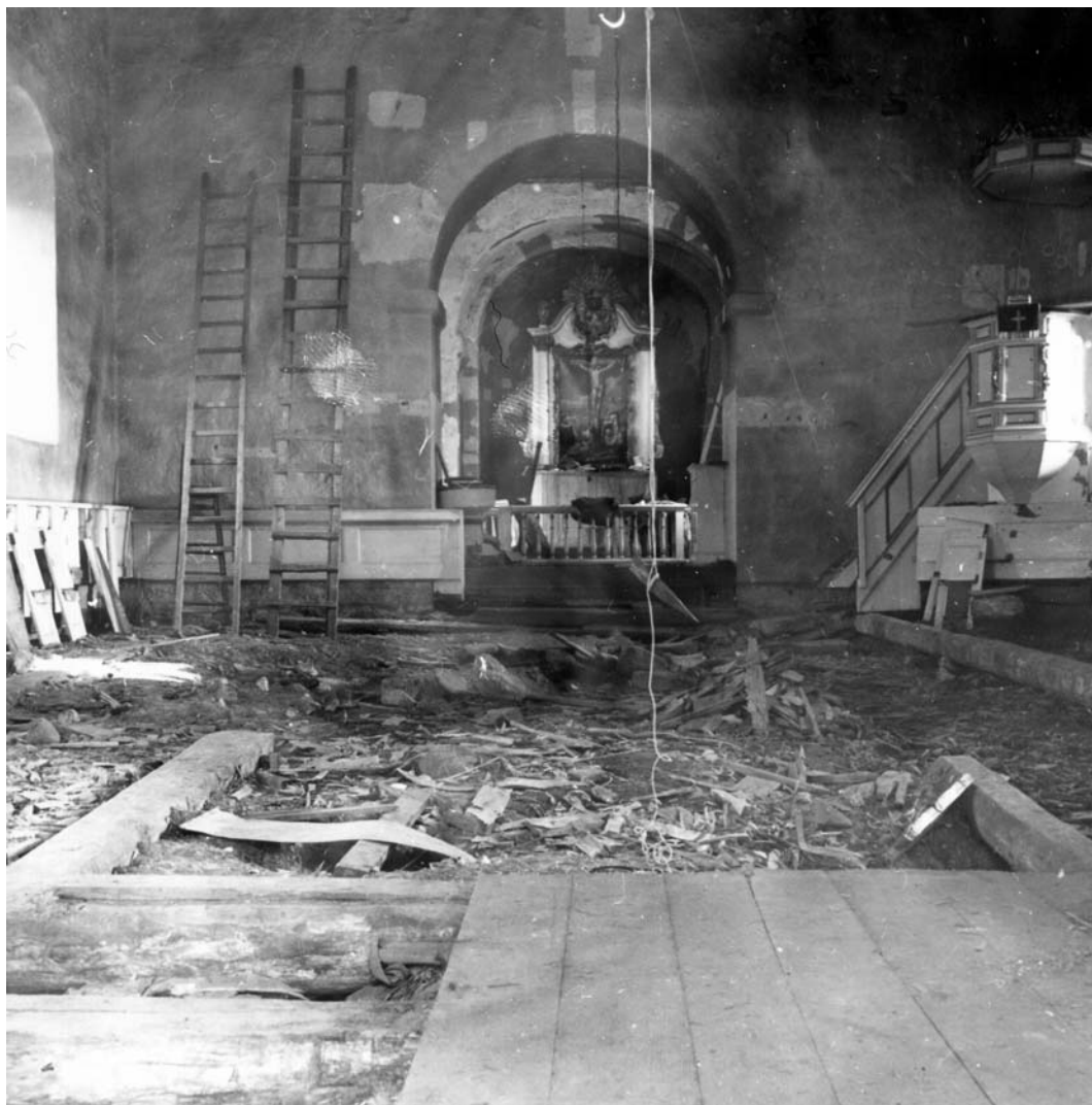
Gulvet i kirkeskipet var svært morkent og ble fjernet. Til høyre i bildet ses prekestolen fra 1620. Foto: Ivar Bruu
