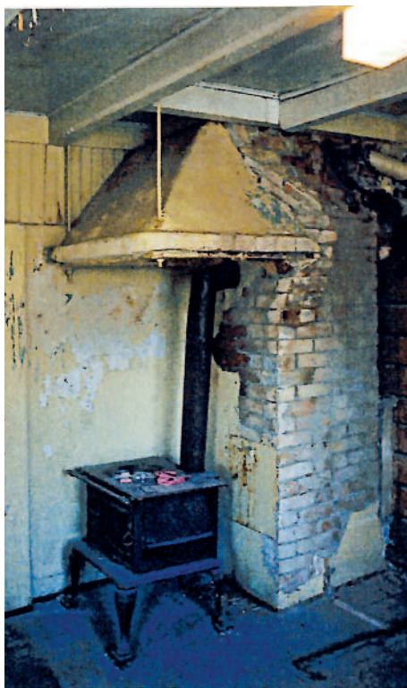
Montering av komfyr i kombinasjon med gruve. Foto: Dag Nilsen.
