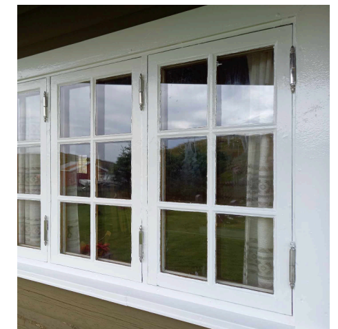
Flott resultat. Nymalte vindu med nye hengsler.
