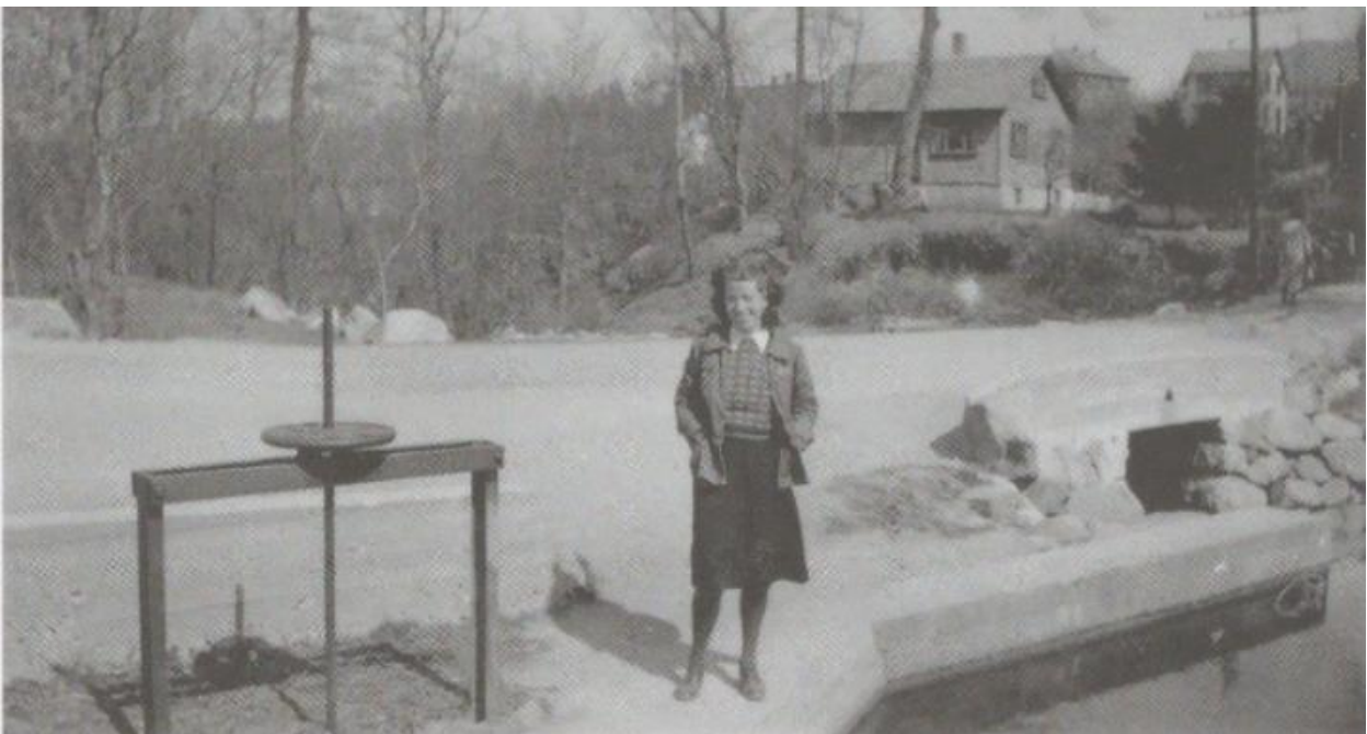
Demning og utløp rundt 1941-42. Tuil vnestre ses innretningen som regulerte vanninntaket til rørgata mot kraftsasjonen til Mølla nede ved Vågen. Fotografert rundt 1910-20. Bildet viser den gamle brua der Bersagelveien før kom ned mot Krossen. (Bildekilde MT 2022:73.)
