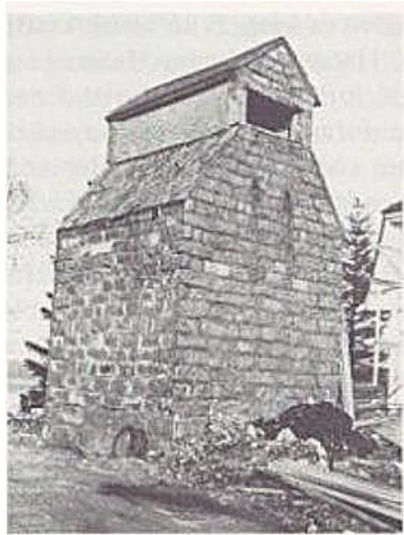
Den første trafokiosken på Breivik i Riska fra 1919-20 var endestasjon for høyspentlinjen fra Fjogstad.
