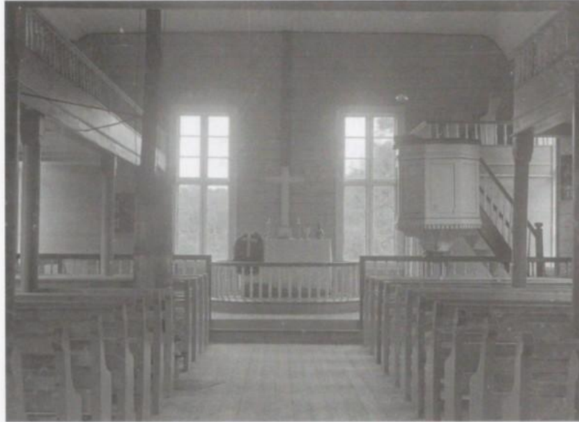
Interiør av kirken fra slutten av 1800-tallet med de opprinnelig vinduene bak alteret. (Bildekilde ON 2022s20.)
