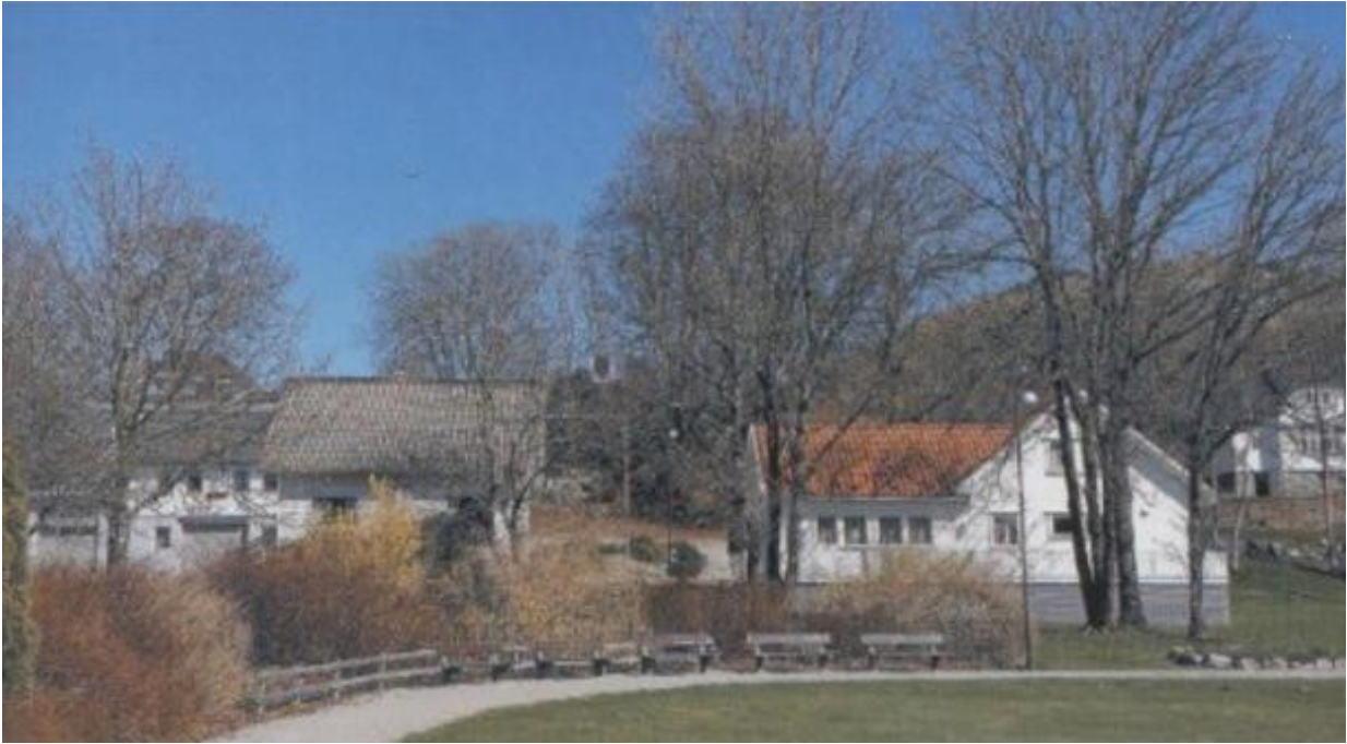
Fra venstre: E-verksbygget, Klokkarhuset og Klokkarlåven på 2020-tallet. (Bildekilde MT 2022:55)
