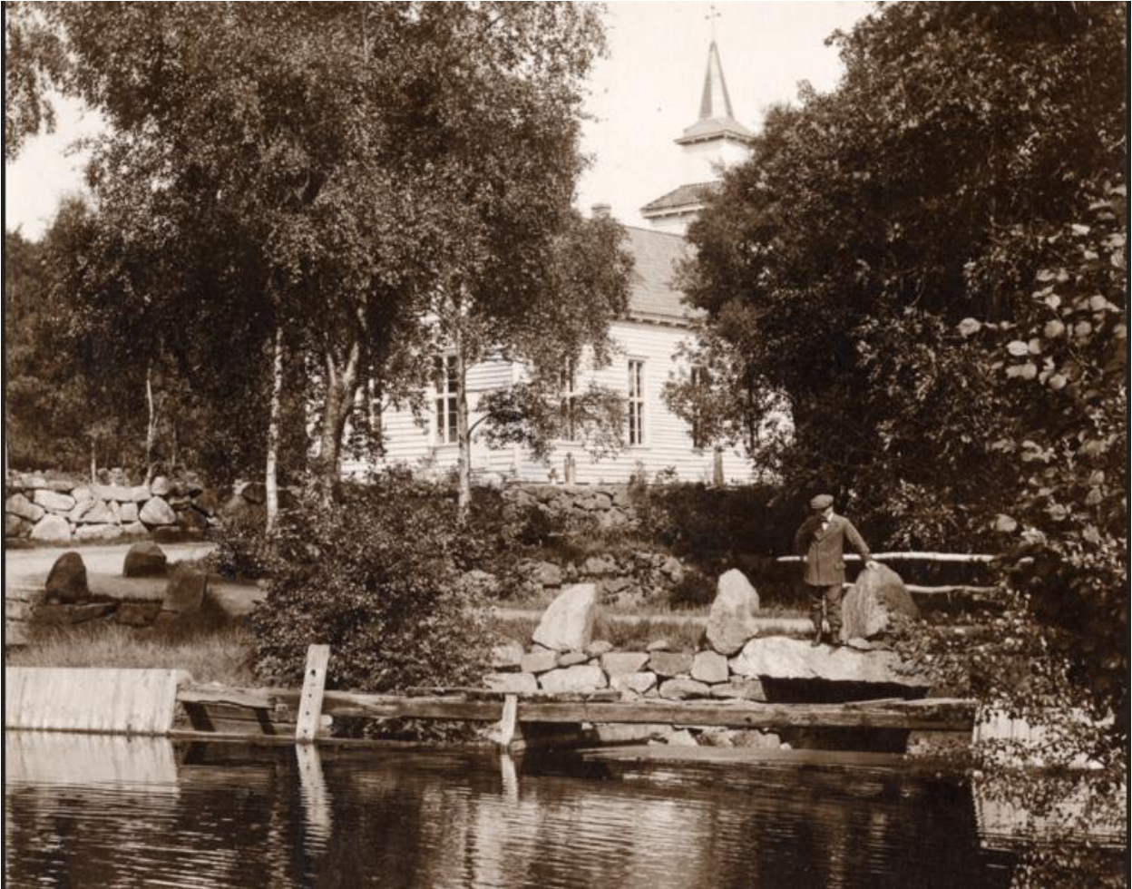
Ved «Stemmabrunå» rundt 1910-15. Bildet viser den gamle steinhellebrua der Bersagelveien før kom ned mot Krossen. (Bildekilde Riksantikvaren T230_0130)).
