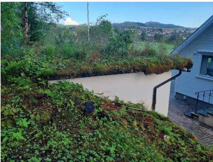
Figur 3 Yttertak med sedum
