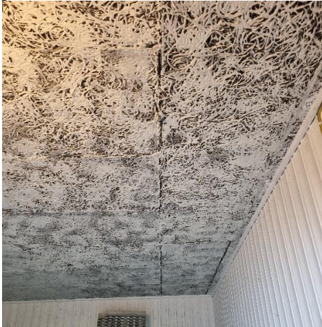
Figur 4 Treullsementplater
