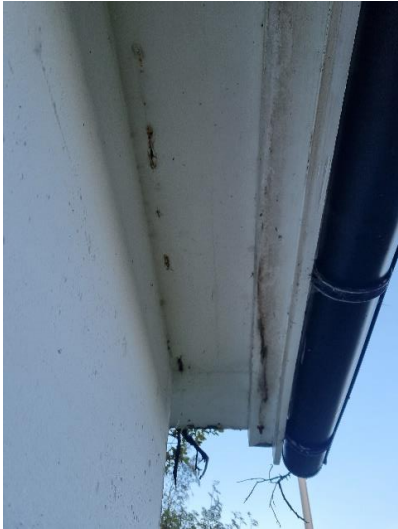
Figur 2 Synlig armering
