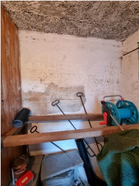
Figur 1 Innervegg mot terreng uten synlige skader
