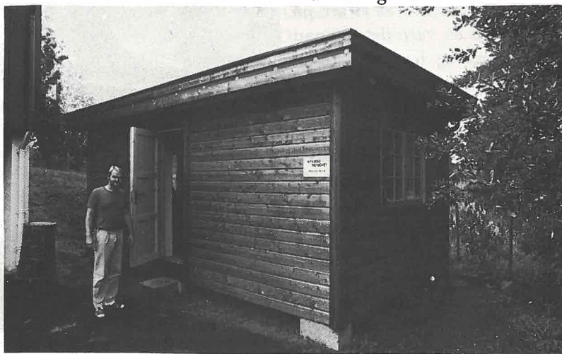
Slik ser det nye prestekontoret på Åmot ut. Det ligger vegg i vegg ved boligen til den residerende kapellan i Doktorveien. Kontoret er blitt praktisk og greitt, og innvendig er det også vakkert og koselig. Det er godt å ha en snekkerkyndig prest i bygda.
