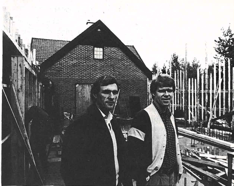
Formann i byggekomiteén Jan Marcussen og daglig leder ved instituttet Per Arne Dahl. Nybygget hoster fire millioner, og er beregnet ferdig neste vår.
