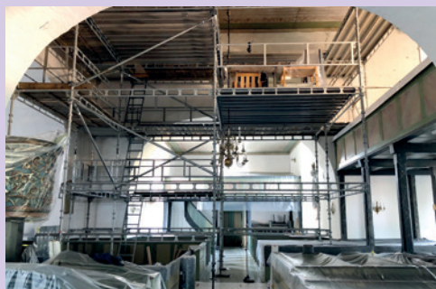
Restaurering i Heggen kirke
