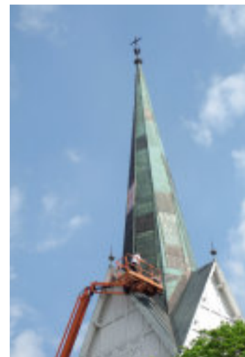
Blikkenslagerne sjekker kirketårnets kobberplater
