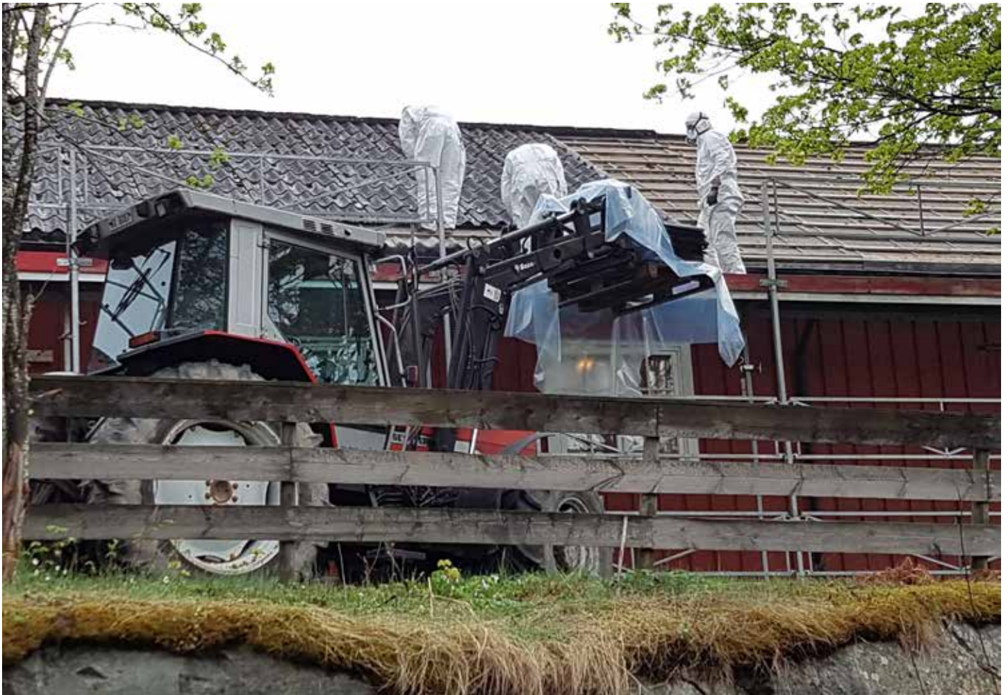
Fjerning av eternittplater. Foto: Vidar Sørby.
