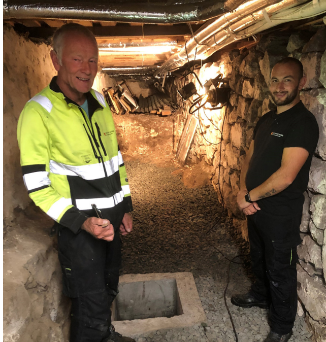
Arne Palmesen og Enird Skendoj har gjort eit storarbeid under kyrkja
