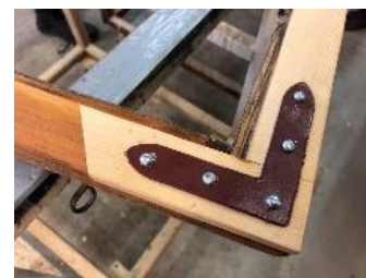
Reparert vindu - vakkert håndverk
