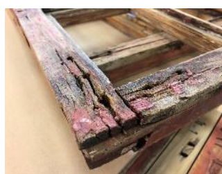
Slik var noen vinduer
