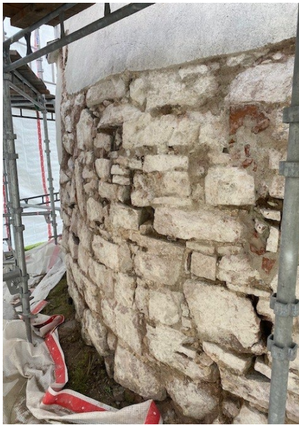
Reparasjon av utvendig mur i apsisbuen mot øst. Foto: Castor kompetanse
