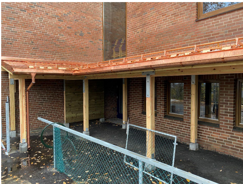
Fra byggingen av nytt skjermtak over inngangen til Østenstad menighetsbarnehage høsten 2023. Foto: Asker kirkelige fellestråd.
