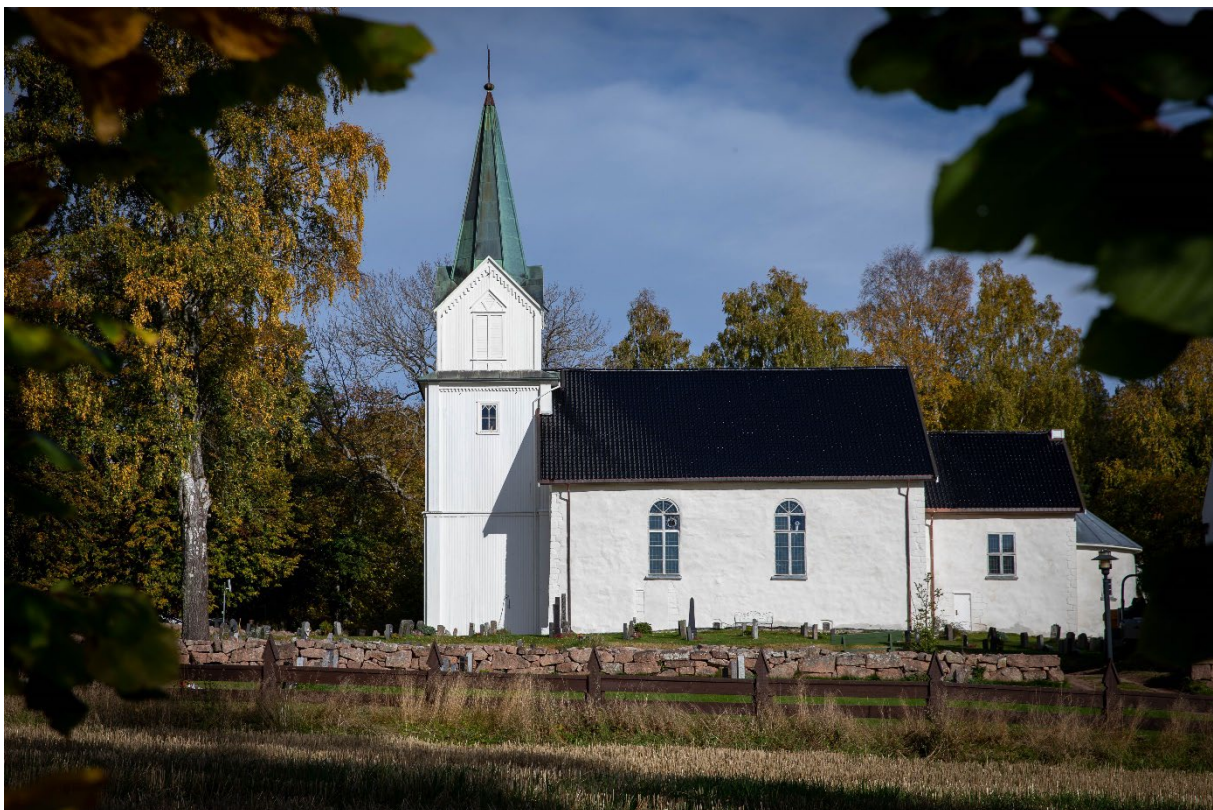
Hurum middelalderkirkes mur mot sør og øst er ferdigstilt. I 2023 ble utvendig mur mot nord og Huitfeldtkapellet reparert og vil bli kalket i 2024. Da vil også innvendig mur mot sør og kirkens vinduer bli satt i stand. Foto: Pål A. Berg
