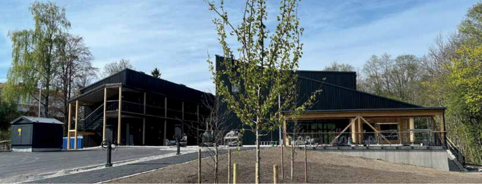
NYVARMESTUE: – Byggingen går etter planen. Vi planlegger å starte flytting til Askerholmen ved Føyka ganske snart, slik at vi er godt i gang med normal drift i nye lokaler før fellesferien tar til. Vi gleder oss! sier gateprest Kjetil Borgenvik. Foto: Svein-Ivar Fors.
