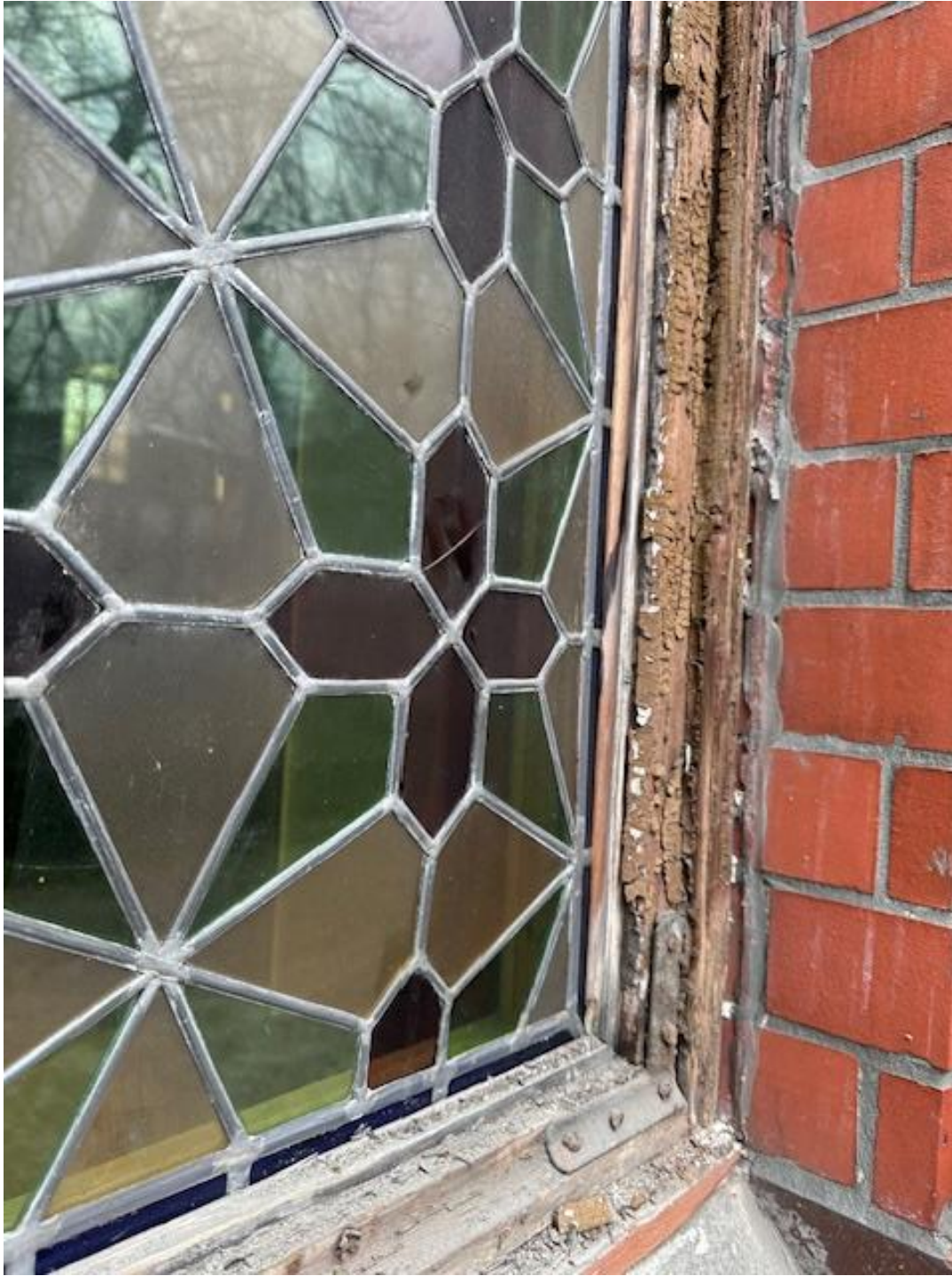
Vindu nr Ø 109. Store utbøyinger som også her resulterer i at glass sprekker.
