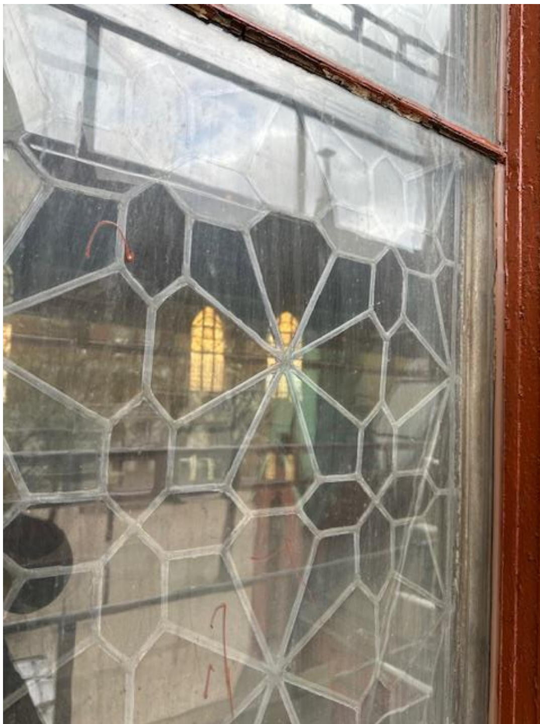
Vindu nr. V 207. Her går utbøyningene i blyglasset helt ut til glasset i varevinduet.
