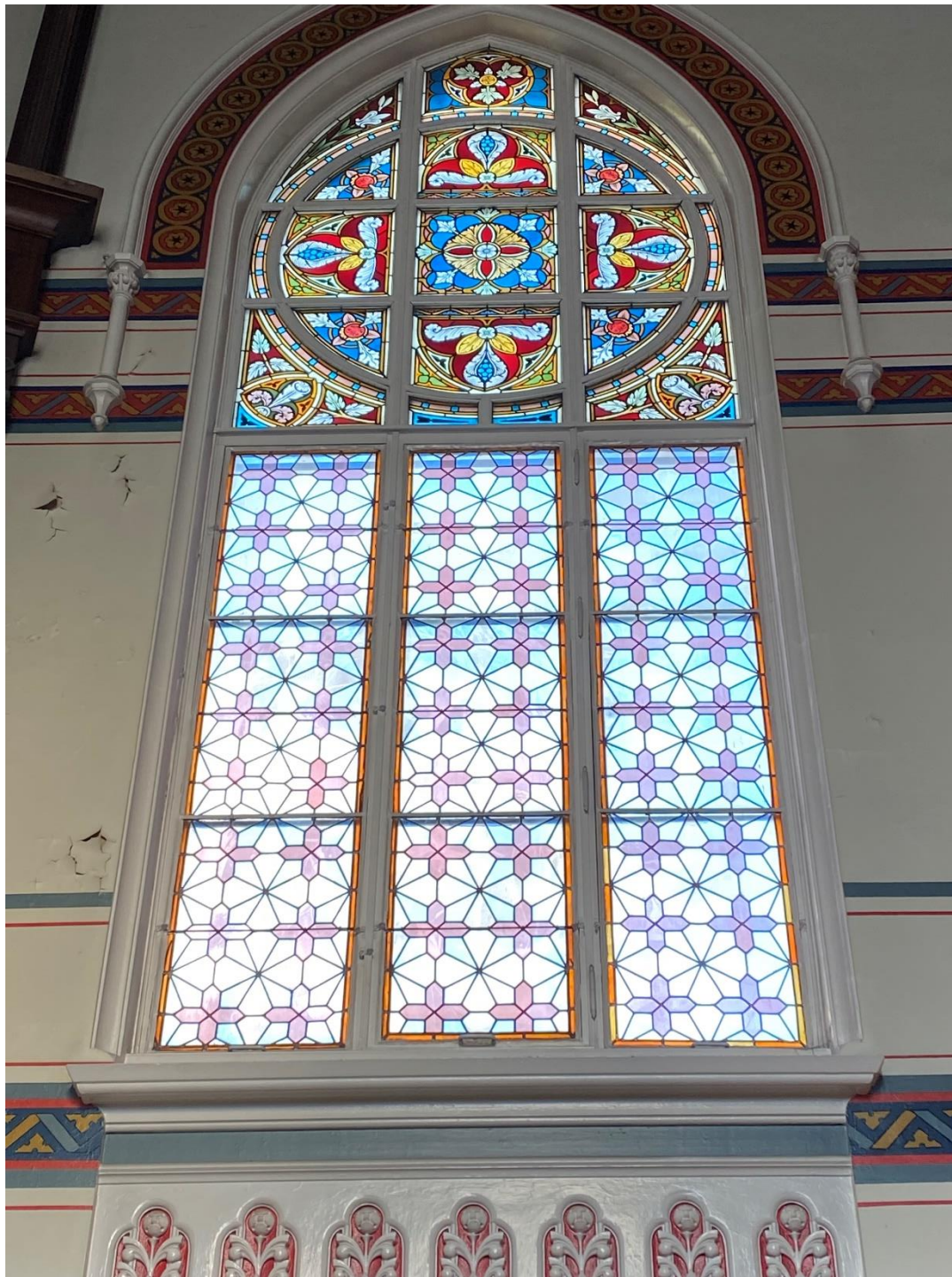
Vindu V 207. (skip) ca 2000 x 5000mm Sjablongmalte sylinderglass i øvre del, farget sylinderglass i nedre del.
