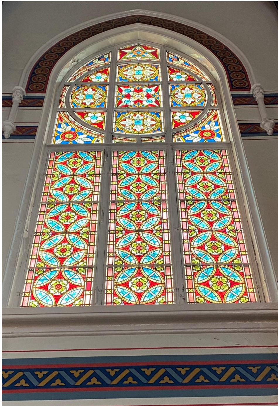
Vindu S 204. (kor) ca 2000 x 5000mm Sjablongmalte sylinderglass i hele vinduet.
