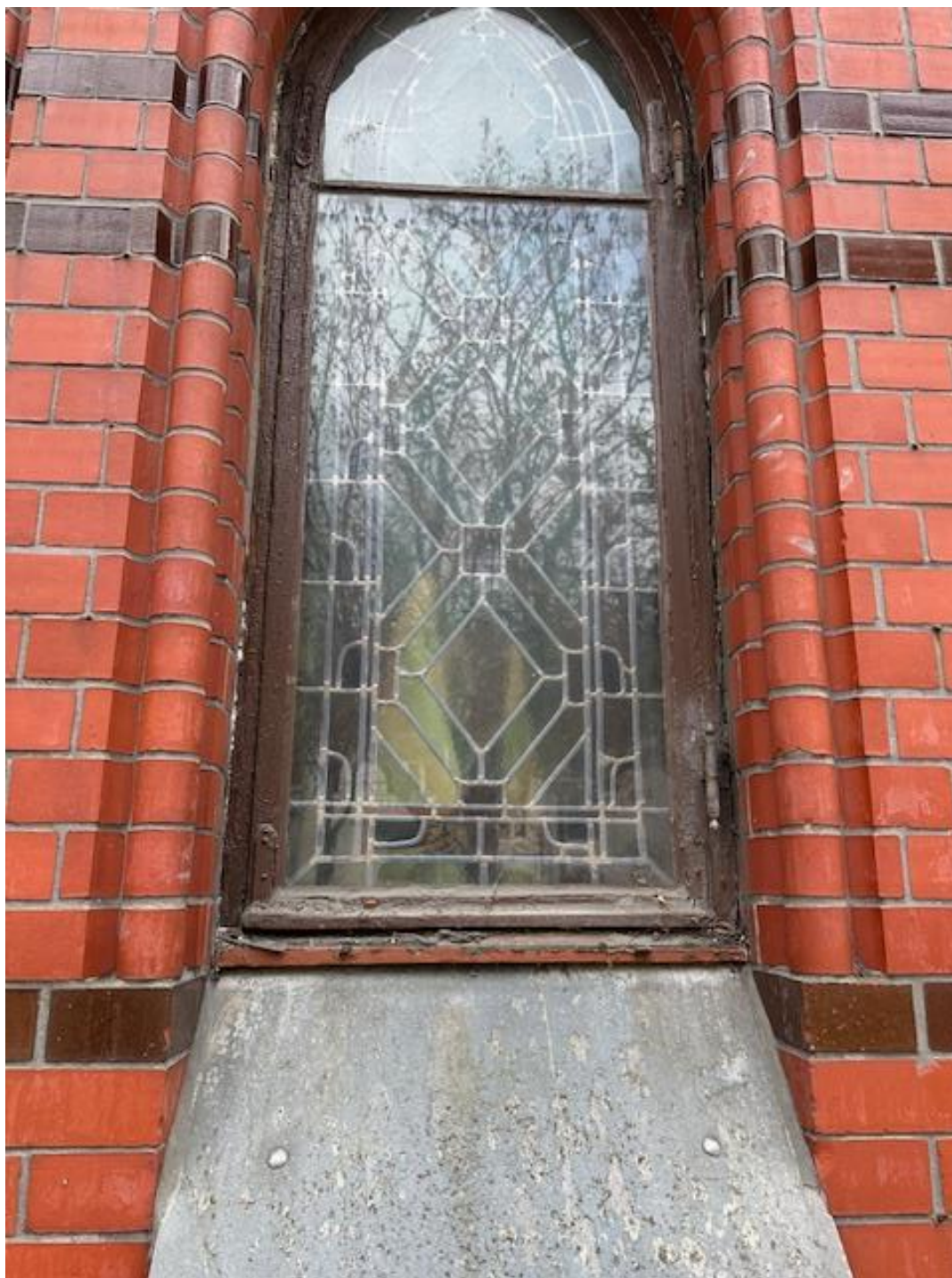
Vindu nr. V 105. Vareglass montert med fugemasse.
