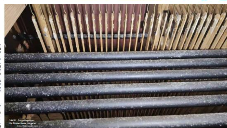
SKALL. Mangelfull kitting av kirkes vinduer svekker klimaskilnet.
