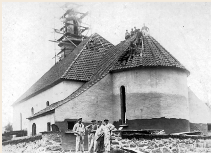
KIRKEN BYGGES: I forgrunnen og på taket ser vi bygningsarbeiderne. Kirken er tegnet av den kjente bergensarkitekten Ole Landmark. (Foto: Ukjent/utlånt fra Harald Toppe i 1999 til 75-års jubileumsheftet)
