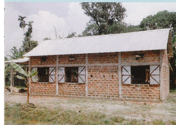
Kyrkja i Gulni, Bangladesh, under konstruksjon og klar for innviing.
