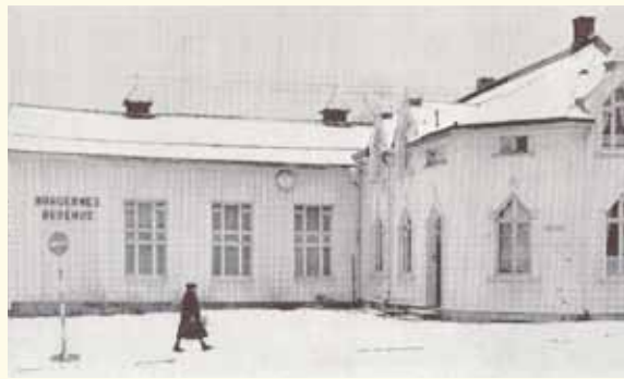
Bragernes bedehus i 1966. Det ble revet i 1978. Den nye bedehus, Indremisjonshuset, ble bygget på Høytorvet (Rådhusgt. 25). Indremisjonshuset ble innviet 8. november 1981.
