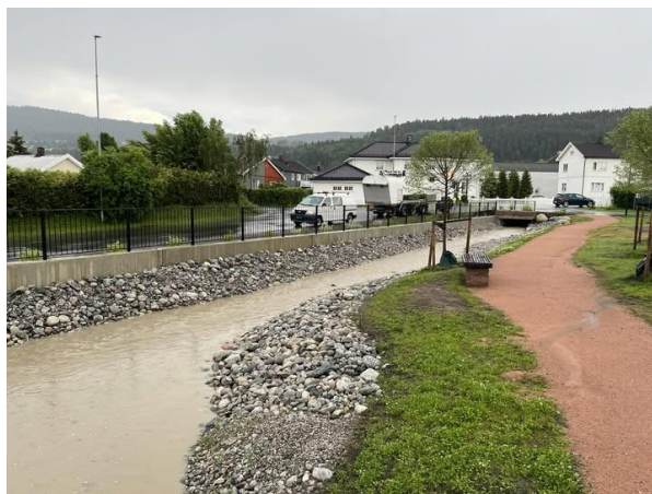
1.juni regnet det rikelig, og flomsikringen til NVE og Drammen kommune fungerer.
