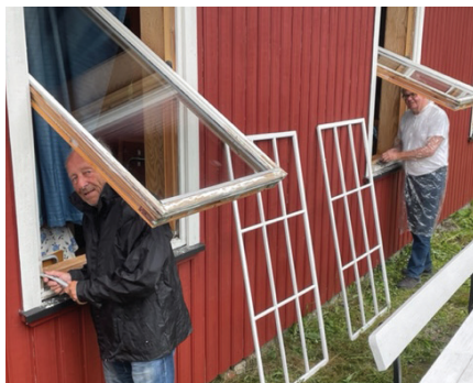
Bjørn Temte og Øivind Hanslien skrapper vinduer.
