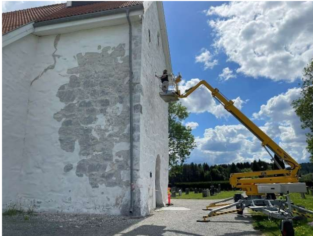
Fjerning av løs kalk etter frostskaide på tårnfoten til Enebakk kirke. Foto: Dag Trygve Baraldsnæs-Henriksen.
