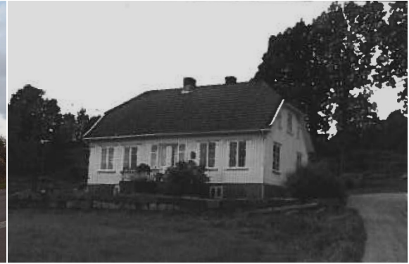
Figur 6-40 På Veierland, nærmere bestemt Tangen, står dette empirehus med halvvalmet mansardtak som representerer det som ofte kalles for «skipperhus». Her med stående panel og markert grunnmur.
