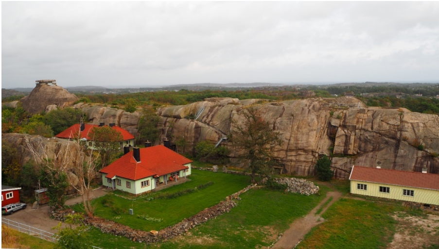
Figur 6-28 Deler av Torås fort, sett mot nordøst fra en av kanonstillingene. Hele området utgjør en nasjonalt verdifull sammenheng. Anleggene og bygningene er forskriftsfredet, men ikke miljøet som binder dem sammen.
