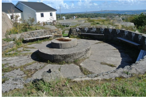
Figur 6-32 Fundament for lyskasterstilling på Tjønneberget på Hvasser, oppført i tilknytning til en rekke andre stillinger og observasjonsposter. Bygningen i bakgrunne var tilhørte tidligere forsvaret og er nå DNTs serveringshytte med overnattingsmulighet. Foto: Geir Sætervik
