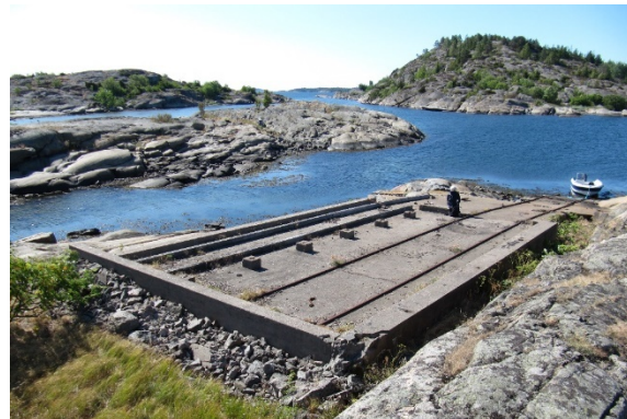
Figur 6-17 På Nordre Mostein står restene fra en bygning med jernbaneskinner for opphaling av sjømerker, samt bryggeanlegg. Slike spor og anlegg finnes på mange av øyene i skjærgården. Eldre flyfoto kan brukes for å forstå dem bedre.
