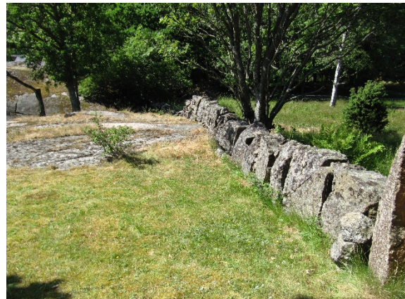
Figur 6-23 Burø. Større bruddstein nøye sammensatt, med grindstolpe til høyre.
