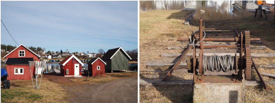
Figur 6-14 Dette miljøet med brygger og sjøboder ved Myrasundet er avsatt til hensynssone bevaring (H570_9). Utover bygninger og brygger representerer anlegg og historiske strukturer slik som vinsjen viktige verdier for forståelsen av miljøet.
