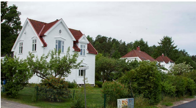
Figur 6-48 Granveien 36 på Nøtterøy utgjør et godt eksempel på en bygning med nyklassisistisk detaljering. De smårutete vinduene i øvre rammen viser jugendtrekk. Bilde: Vestfold og Telemark fylkeskommune
