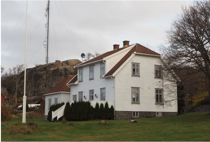
Figur 6-49 Halvvalmet tak og karakteristisk grunnmur av naturstein. Bygningen, som står på Tjøme, fanger opp empirens uttrykk, men vinduene og den høye kneveggen sier oss at det bør være oppført rundt 1. verdenskrig.
