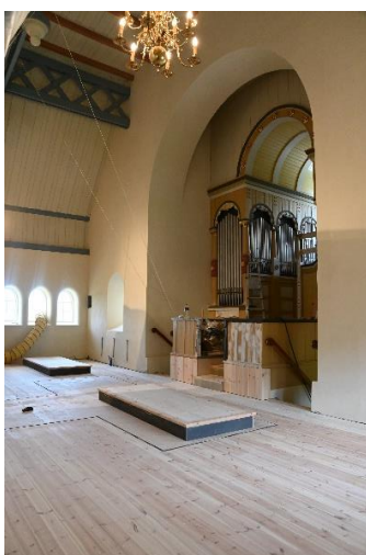
Foto 24.aug 2021 gulvbord på galleriet er gjenbrukt og slipt
