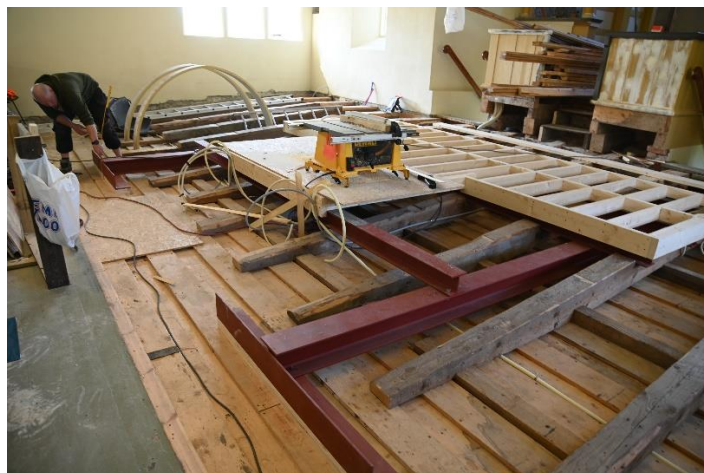
foto 21. mai 2021 ombygging og forsterkning av gallerigulv for nytt orgel
