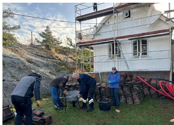
All taksten ble vasket.
