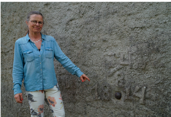
Charlotte viser oss kanonkulen i muren på hovedbygningen.
