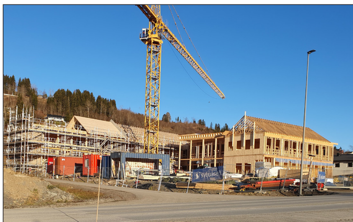
Omsorgssentret har reist seg opp fra bakken
