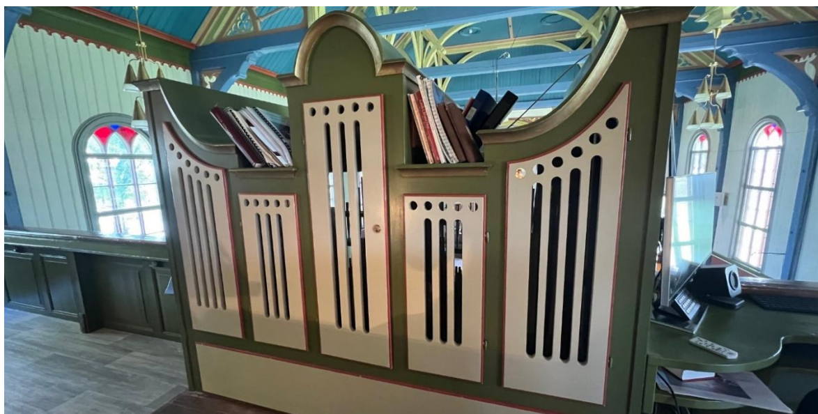
Meir lufting: Nokre av orgelpipene har fått meir ventilasjon, med utfreste sprinklar i frontane. Arbeidet er flott utført av vår lokale handtverkar, Harry Røyset. Foto: Hareid sokn
