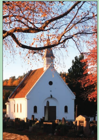
Gravkapellet ble oppført i 1914 og trenger mye oppussing for å bli i topp stand.
