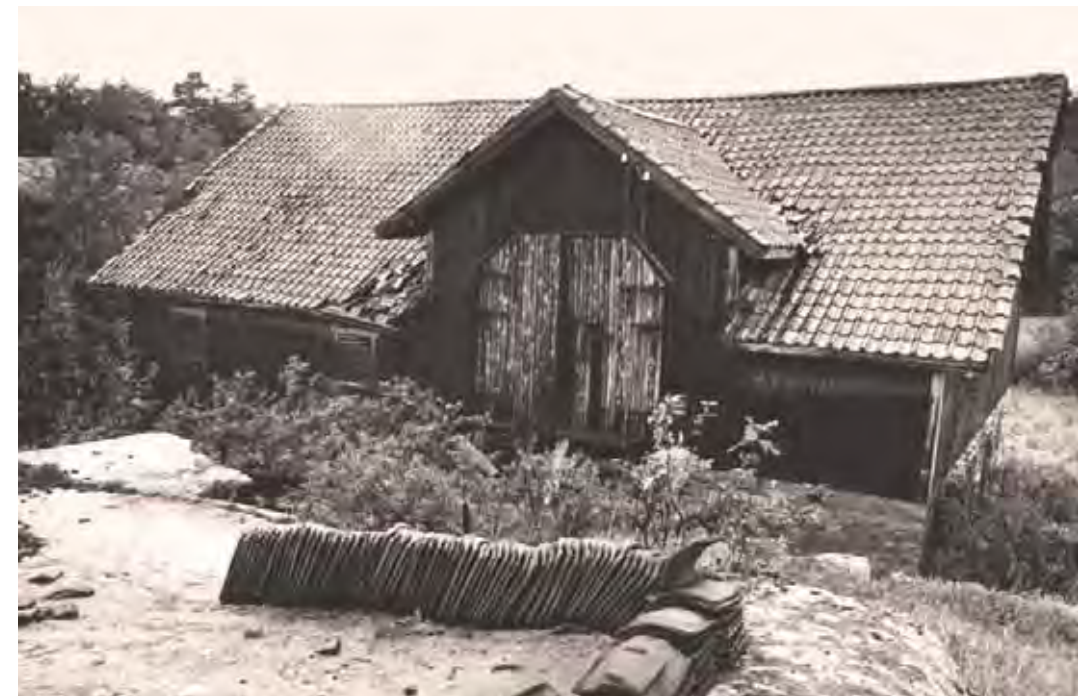
Låven før restaureringen.
