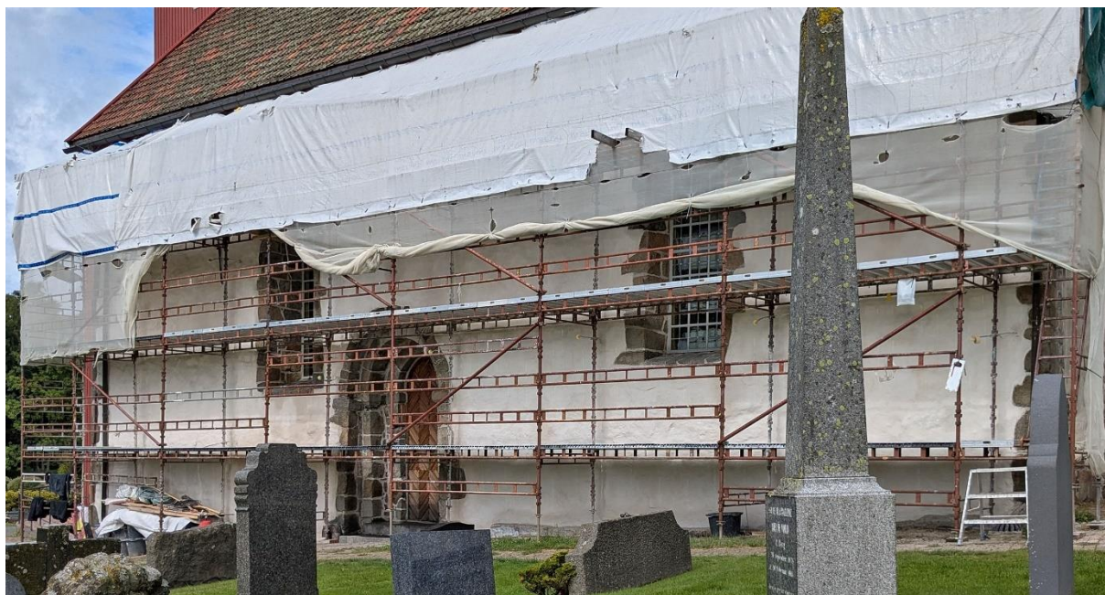
Skipets sørfasade nær ferdig spekket, pusset, slemmet og hvittet 21. august 2024.
