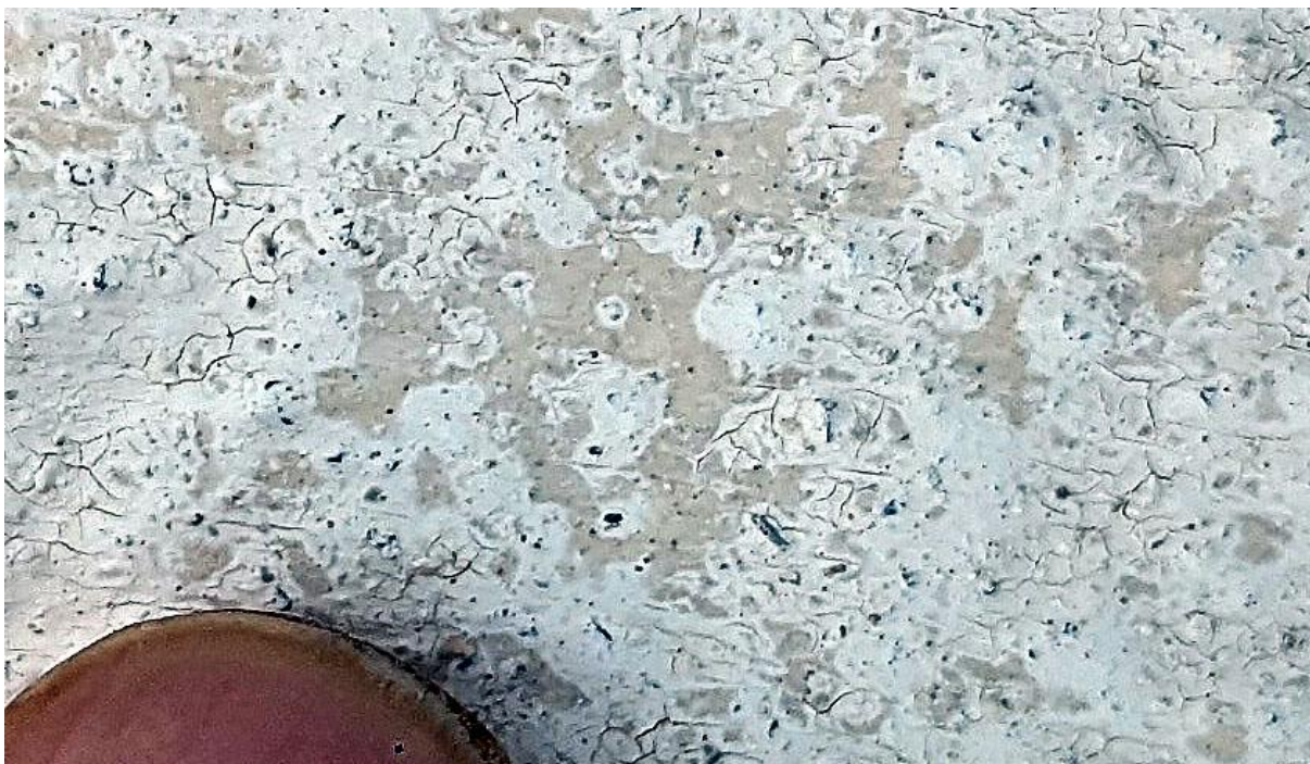
Figur 19: Nærbilde av små, gullige flekker og små krakeleringer i hvittingen. Foto fra 21. august. Kontrast og farge er endret noe i Photoshop for å få frem fenomenene. Fingernegl som målestokk.
