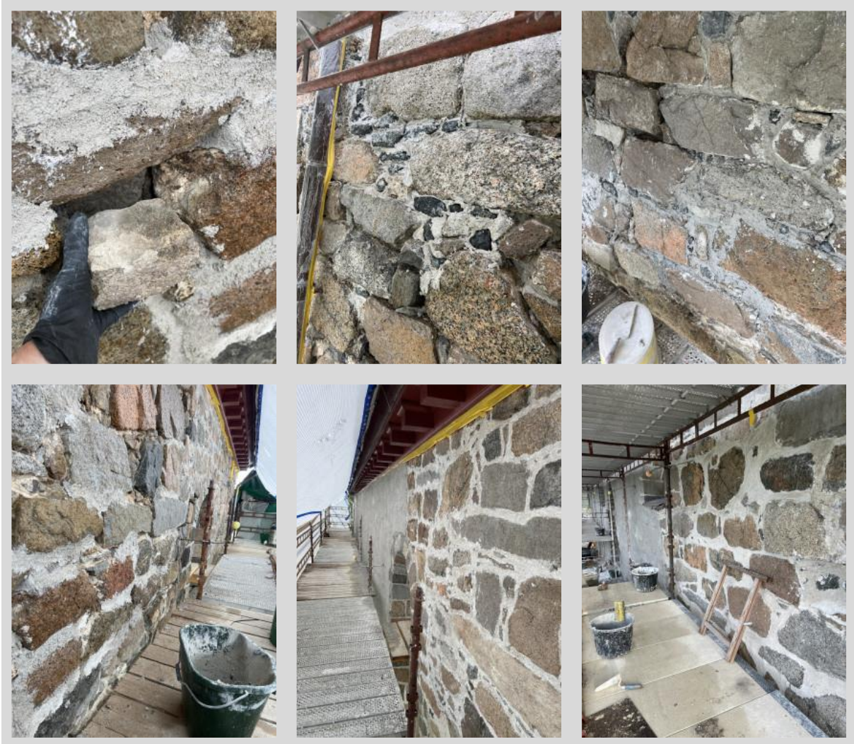
Figur 4: Inntrykk av arbeidsprosessene. Øvre rad: Innmuring av pinningstein og spekking. Nedre rad: Spekking, meddratte fuger dels over stein og pussing av vestre del av veggen. Fotos: Murmester Mannhart.
