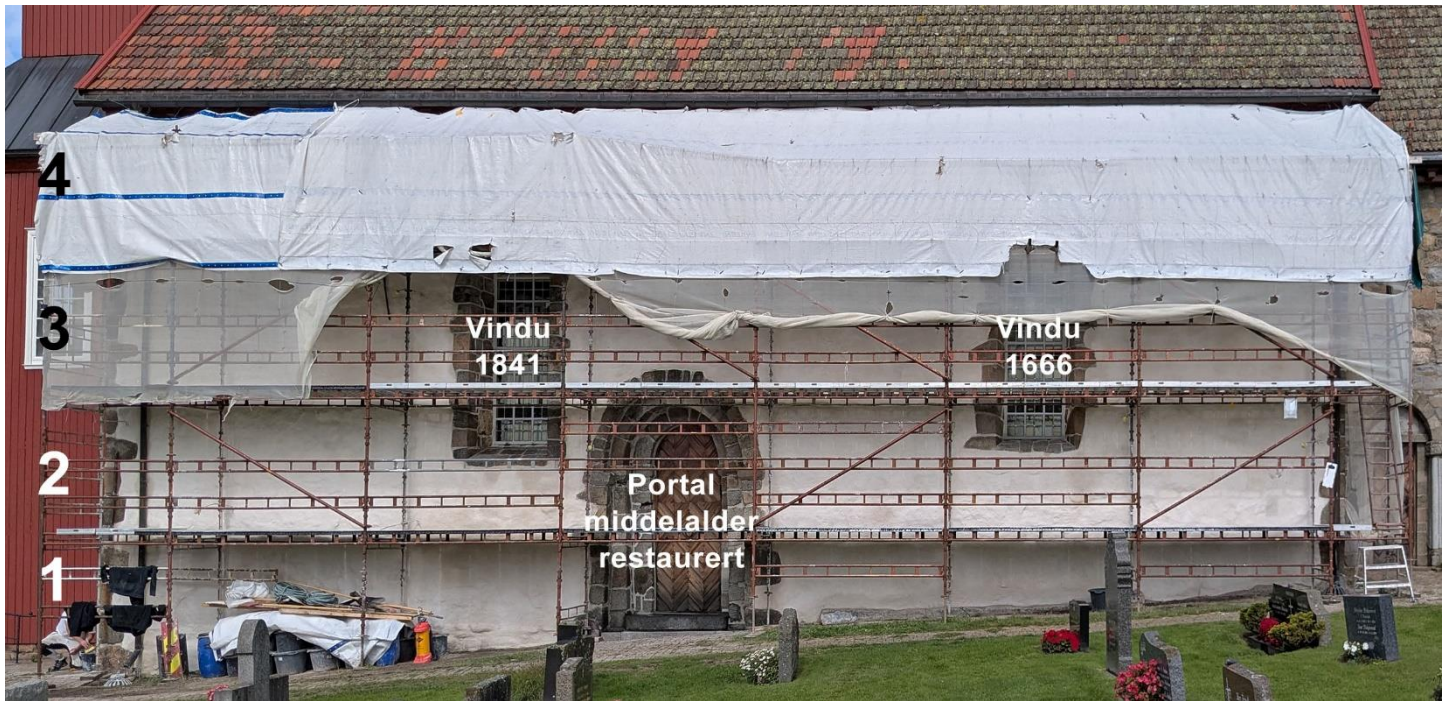
Figur 1: Oversikt over sørveggen til skipet ved nær ferdig behandling i august 2024, med stillasetasjer og åpninger som kun er spekket/fuget.
