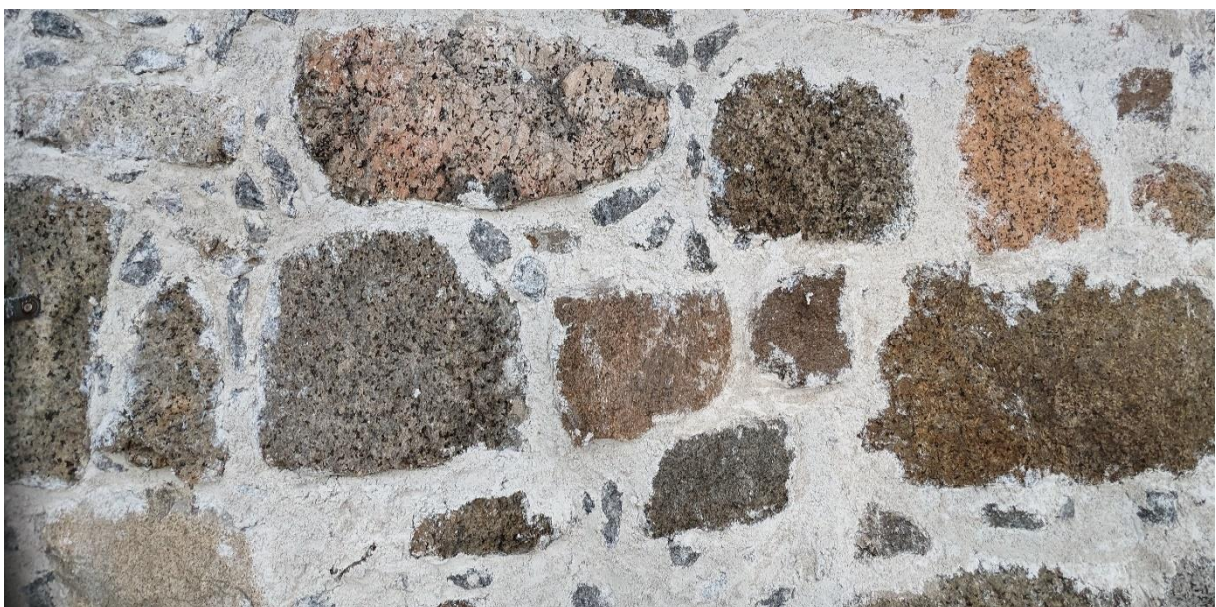
Figur 5: Ferdige, dels meddratte fuger med pinningstein synlig før pussing.
