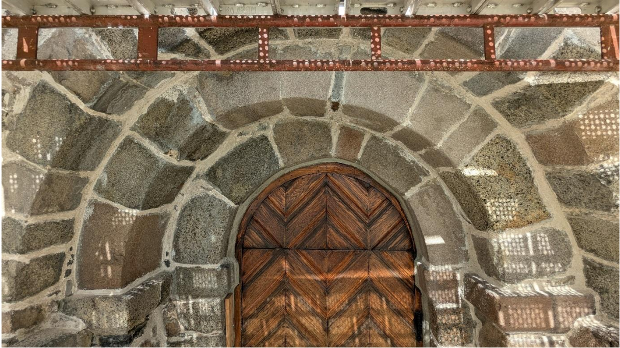
Figur 14: Buene til portalen etter første gangs spekking.
