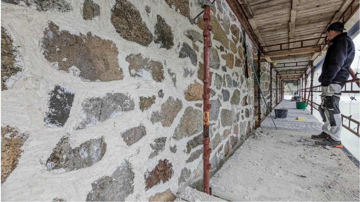
Figur 6: Mer utpregede meddratte fuger før pussing.
