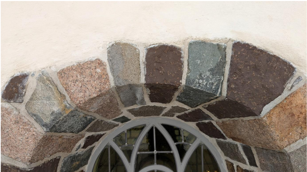
Figur 9: Inntrykk av puss og fuger omkring det vestre vinduet.
