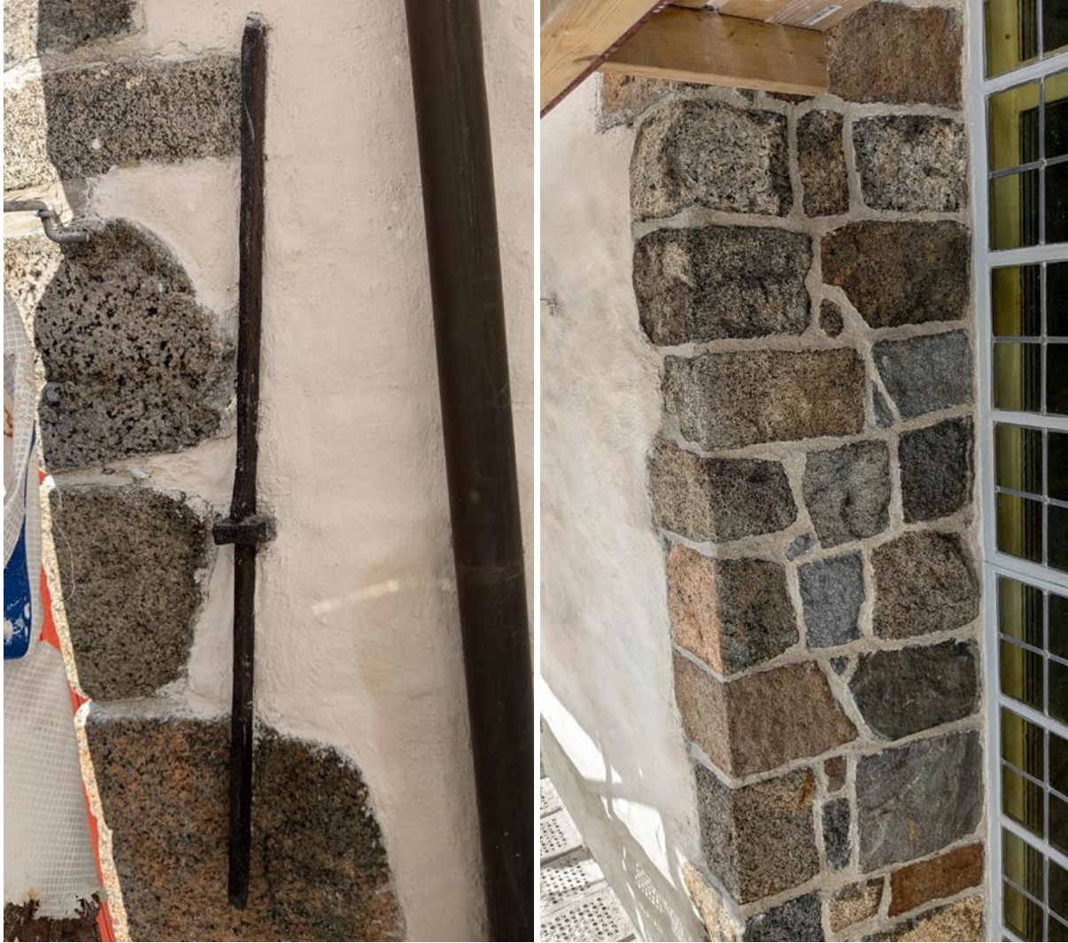
Figur 10: Venstre: Inntrykk fra hjørnesteinene mot vest, med eldre muranker som under restaureringsarbeidet ble behandlet med Ovatrol. Høyre: Inntrykk fra vindussmyget i det vestre vinduet.
