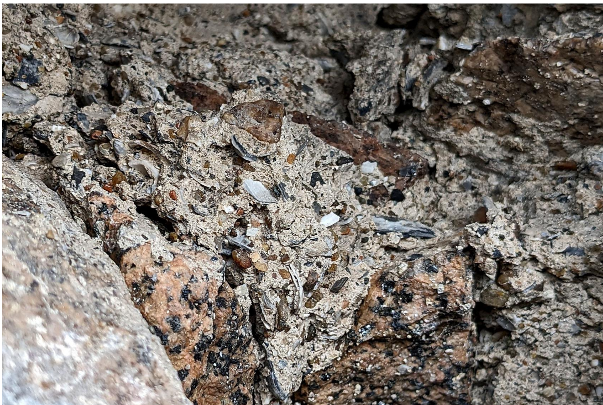
Figur 21: Eldre kalkmørtel med store mengder skjell i tilslaget, fra de nedre deler av murverket rett vest for sørportalen.
