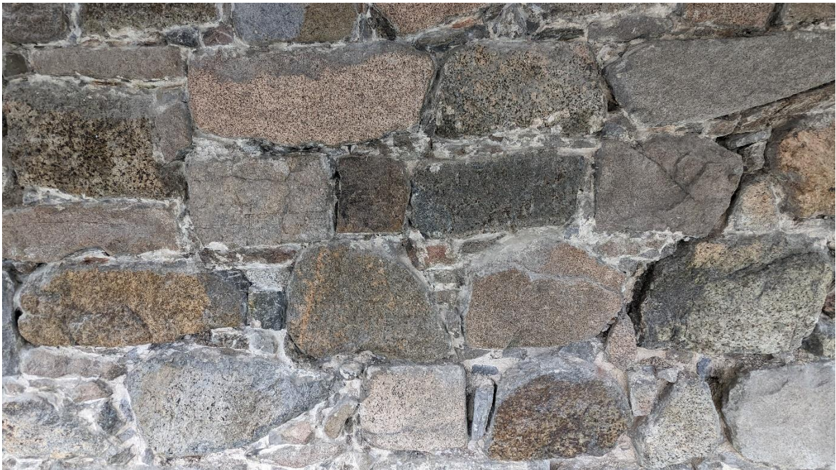
Figur 3: Inntrykk av noe av det beste gjenstående, middelalderske murverket i den østre delen av skipets sørvegg etter at sement ble hogd bort i 2023.
