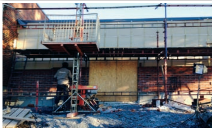
Ytterveggen på tilbygget er snart ferdig murt.
