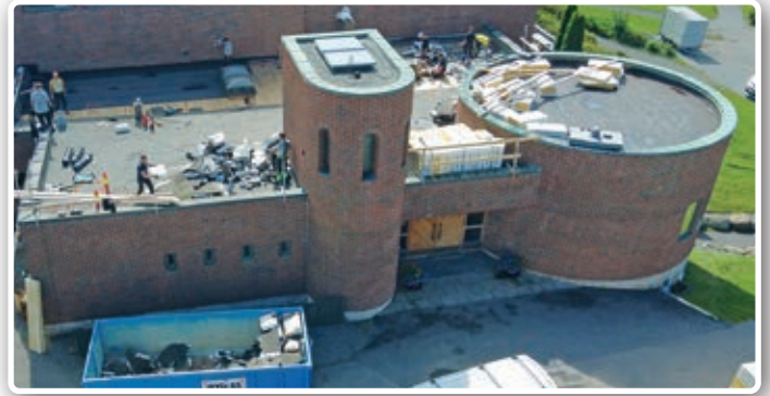
Hele taket er byttet, både isolasjon og tekking.
