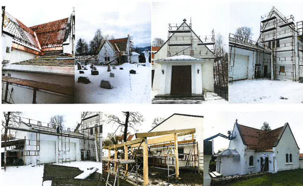
Bilder underveis i arbeidet
