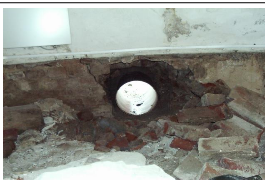
Det ble hogget fram 9 tommer ventilåpninger på i alt 8 steder
