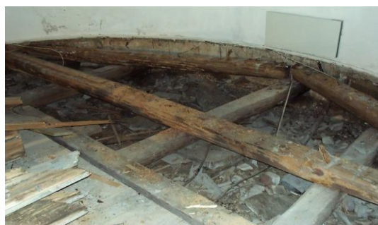
Stokkene i koret var sterkt angrepet av råte
