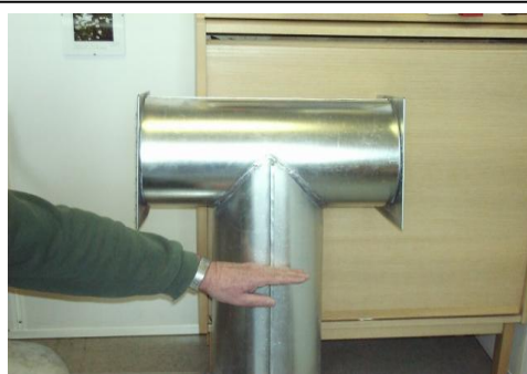
Da ventilåpningene var svært mangelfulle måtte nye og større dimensjoner benyttes.
