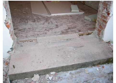
Den gamle inngangen gjenåpnes
