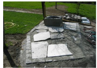
Ny vannpost og benkplass
