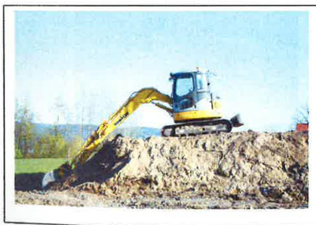
Utvidelsen av Tranby kirkegård er et omfattende arbeid: Drenering og utskifting av jordmasser.
