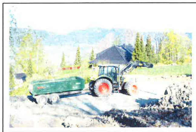
Utvidelsen av Tranby kirkegård er et omfattende arbeid: Drenering og utskifting av jordmasser.
