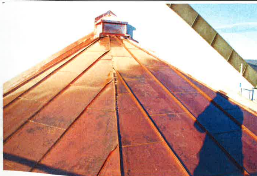
Full kobbertekking m/takrenner og nedløp
