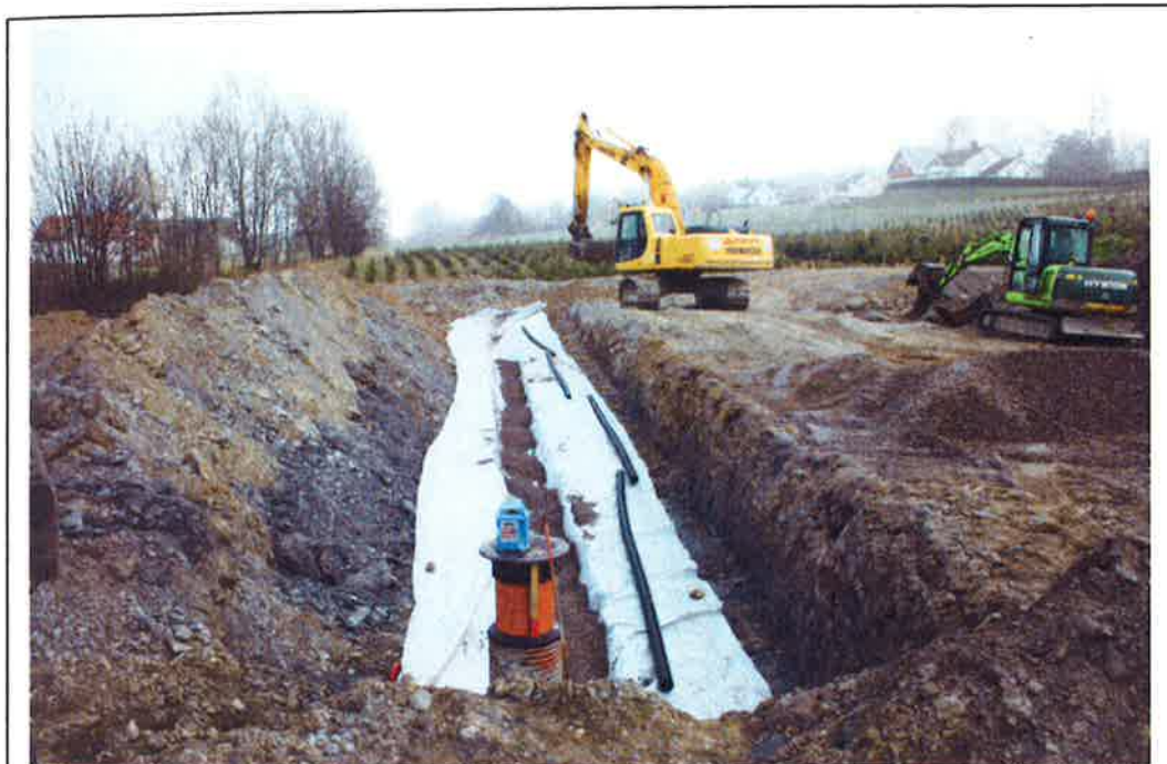
Utvidelsen av Tranby kirkegård er et omfattende arbeid: Drenering og utskifting av jordmasser.
