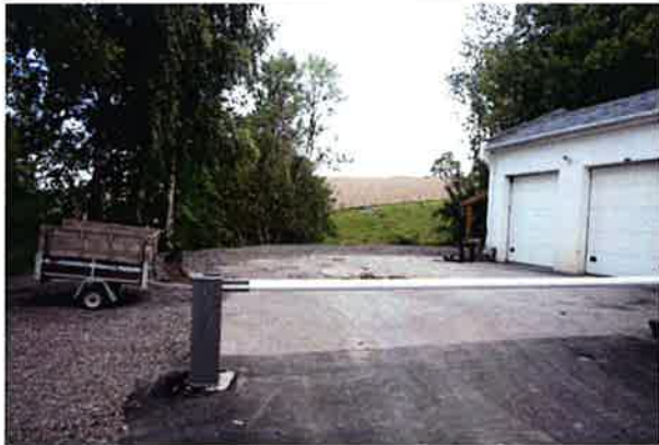
Det ble ryddet for trær og kratt og fylt på med knust asfalt
