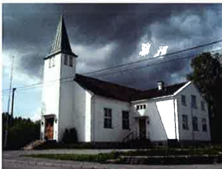
Lierskogen kirke stengt onsdag 12. november p.g.a. store råteskader i gulvet.
