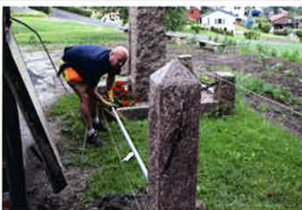
Arbeidet ble utført av Lier Drift,
