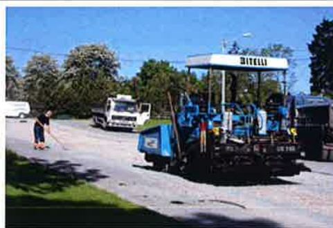
Ny asfalt på parkeringsplassen
