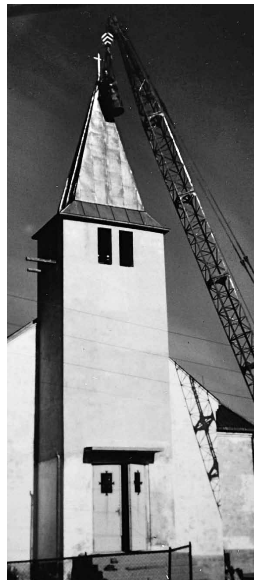
Til slutt festes korset på spirets topp. Kåre Kværnstuen er heist opp i ei tønne for å utføre arbeidet. Foto: Osvald Kværnstuen
