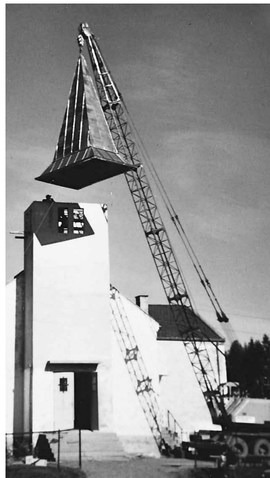
Spiret er ferdig beslått med kopper utført av Osvald og Kåre Kværnstuen.
