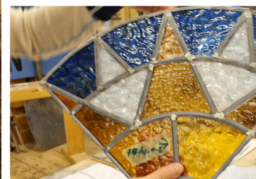
Rehabilitering av blyglassvinduer. Foto: Harald Ringstad
