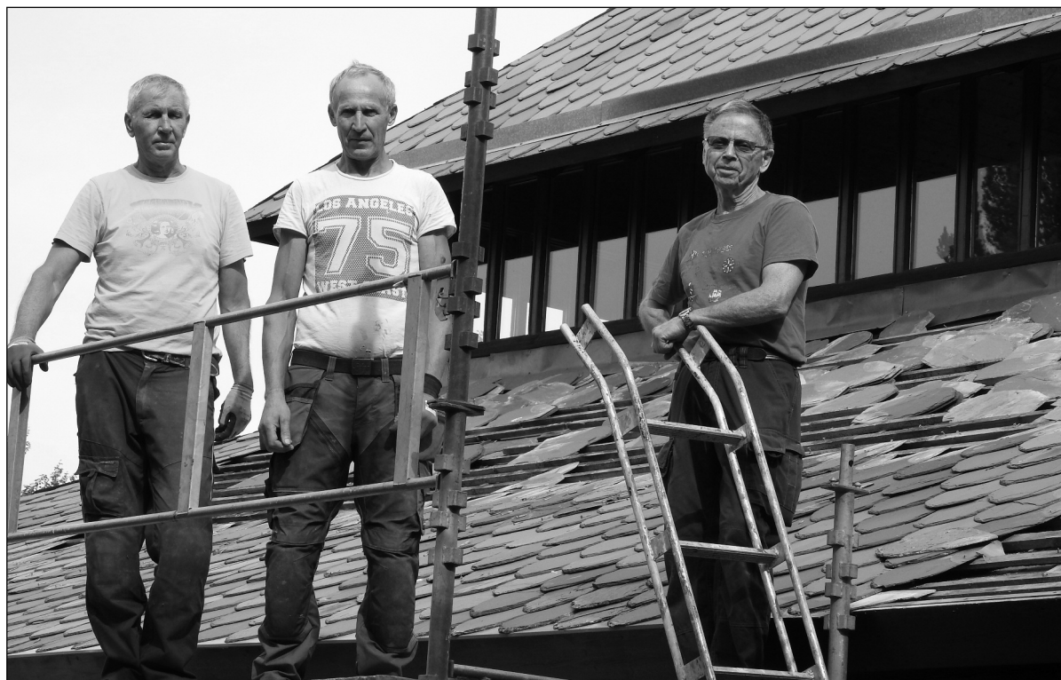
Åsmund Naustdal (til høyre) i styret for Aurdal fjellkirke er glad for at det nå er blitt lagt ny skiferstein på kirke. Her er han fotografert sammen med to litauiske arbeidere som er ansatt hos tømrermester Odd Arne Rudi som har stått for utbedringene. (Foto Hans Enger)
