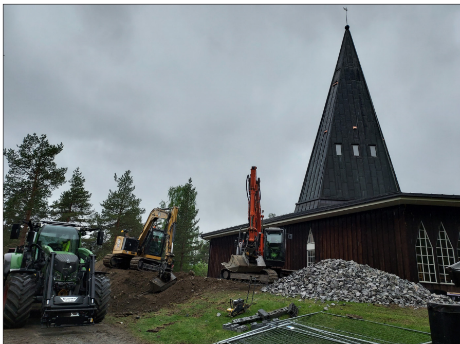
Tingnes kirke, graving gravemaskiner uttafor hovedinngang
