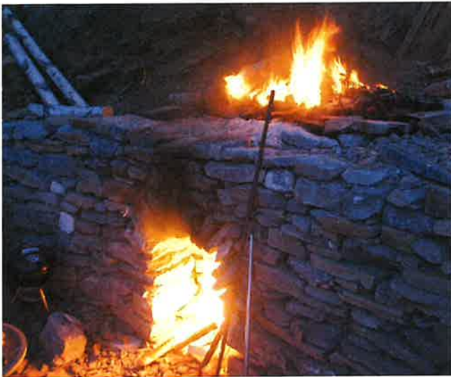
I slike ovner brant man kortreist kalk med ved fra middelalderen til slutten av 1800-tallet. Dette er en ny tradisjonsovn på Helgøya med kapasitet på ca. 16 tonn pr. brenning. Hver brenning tar ca. 3 døgn.
