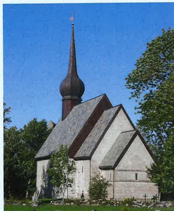
Alstadhaug kirke er fra år 1100 og ligger i Nordland fylke. Vernestatus: fredet.
