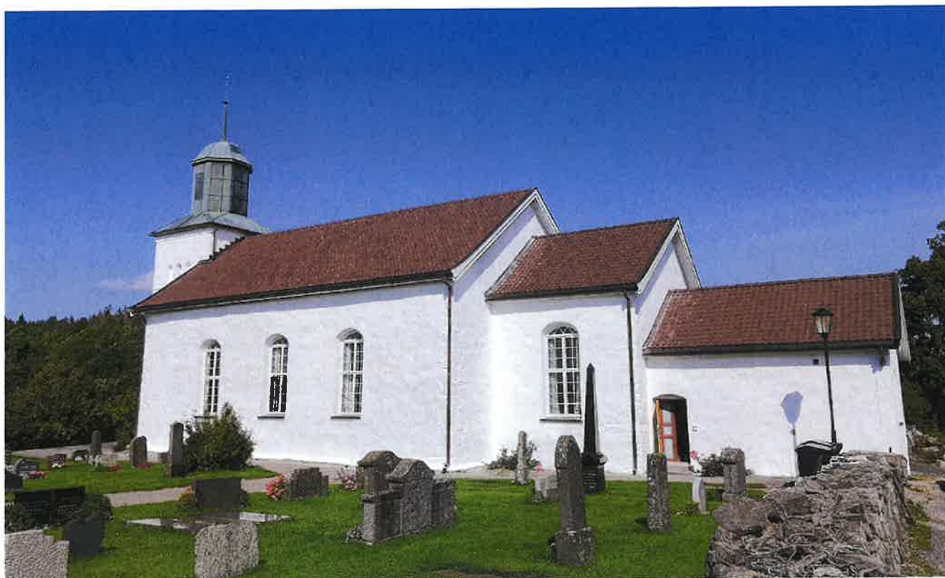
Botne kirke ferdig istandsatt med kalk. Botne kirke er fra år 1200 og ligger i Vestfold fylke. Vernestatus: fredet. Foto: Geir Magnussen.
