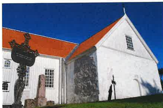
Tromøy kirke er fra år 1150 og ligger i Agder fylke. Vernestatus: fredet.
