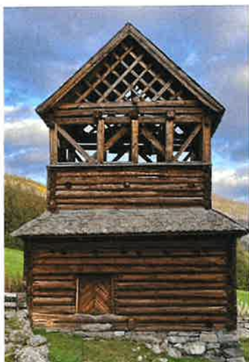
Støpul ved Lomen stavkyrkje. Lomen stavkyrkje er fra år 1180 og ligger i Innlandet fylke. Vernestatus: fredet.
