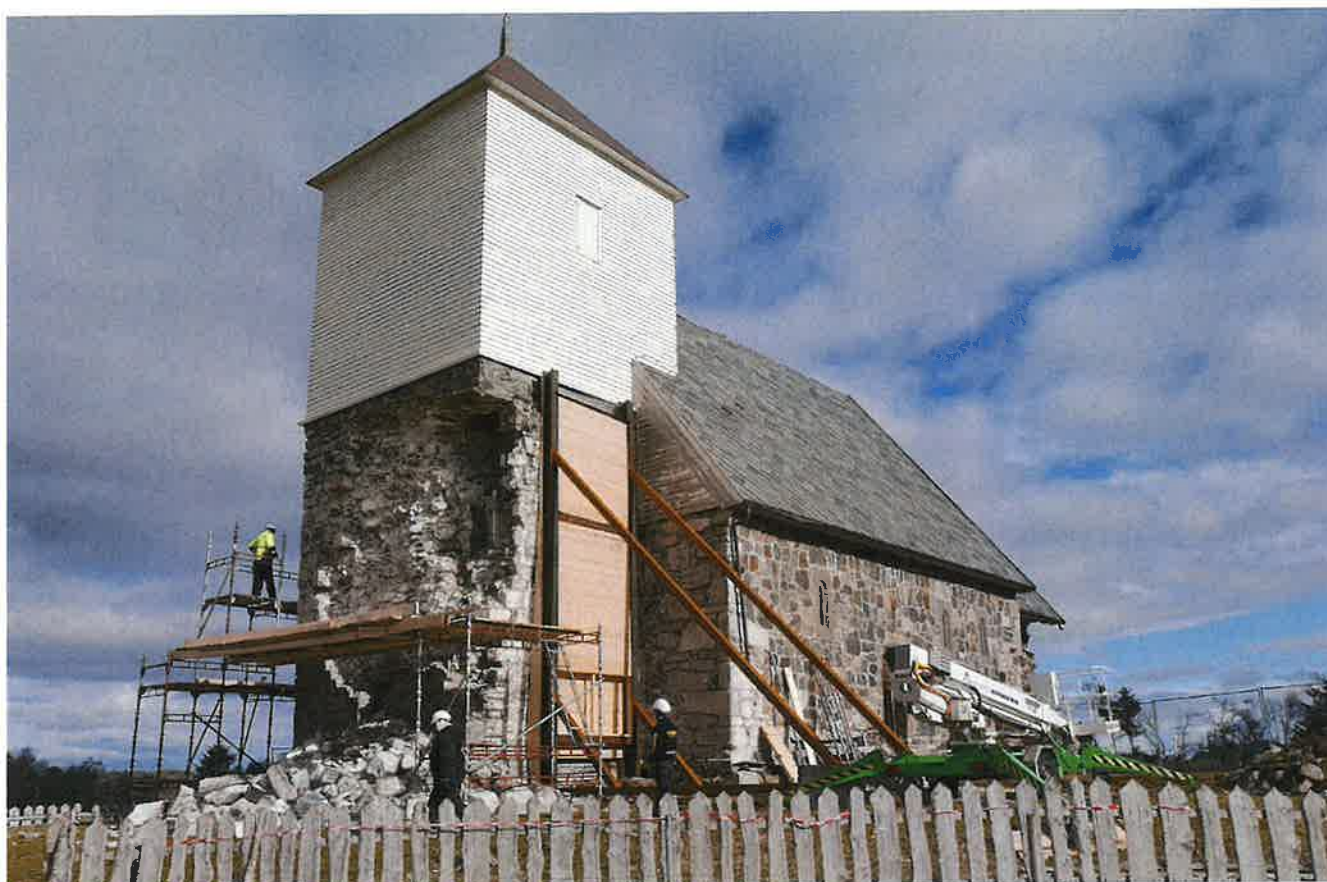
Nærøy gamle kirke under restaurering i 2017. Nærøy gamle kirke er fra år 1100 og ligger i Trøndelag fylke. Vernestatus: fredet.
