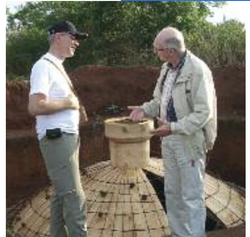
Helge og Johannes drøfter byggingen av biogassanlegget
