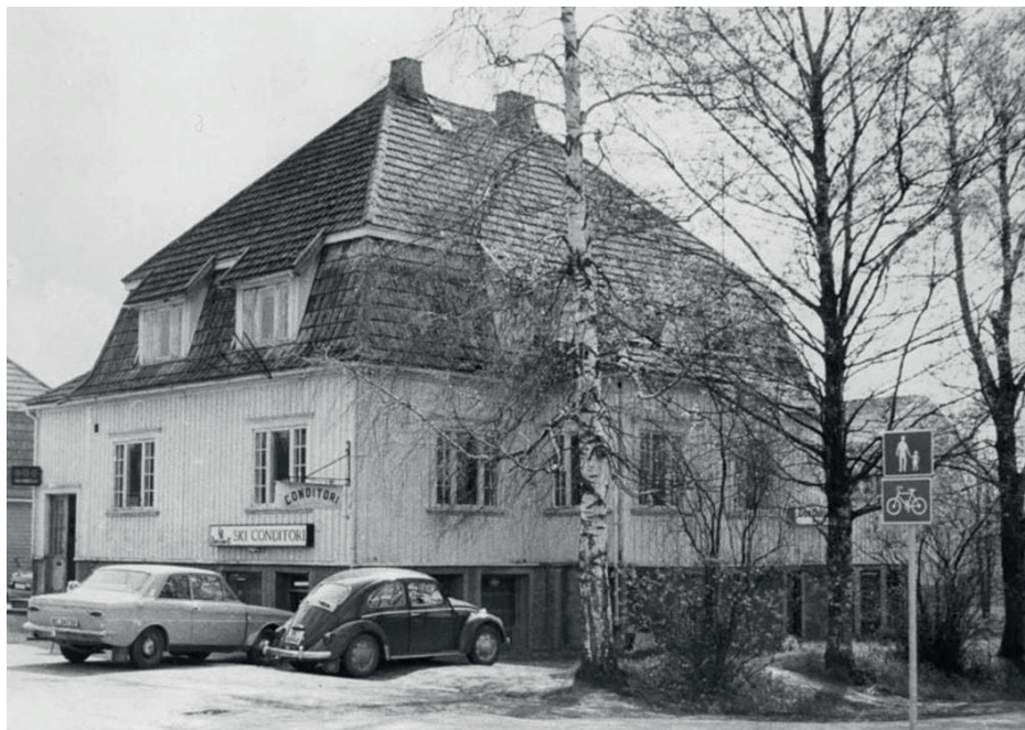
I midten av 1920-årene oppførte Gunerius Hilmar Herrefosser denne bygningen i Ski sentrum. Den var både bolig og inneholdt forretninger, og ikke minst ble den kjent som Condisen etter det populære bevertningsstedet som lå i kjelleretasjen på hjørnet mot torget. Foto Ski historielags kalender
